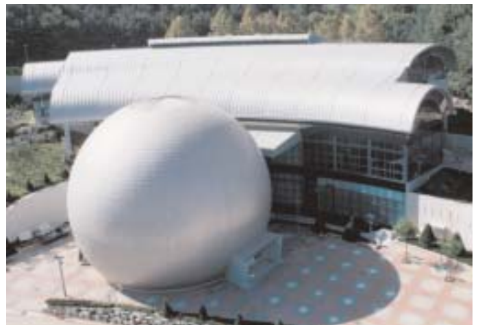
Zinkbedachung in flexibler Bauweise
