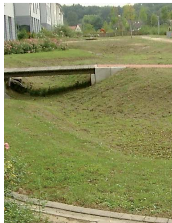
Versickerung des Niederschlagswassers in einer Sickermulde
