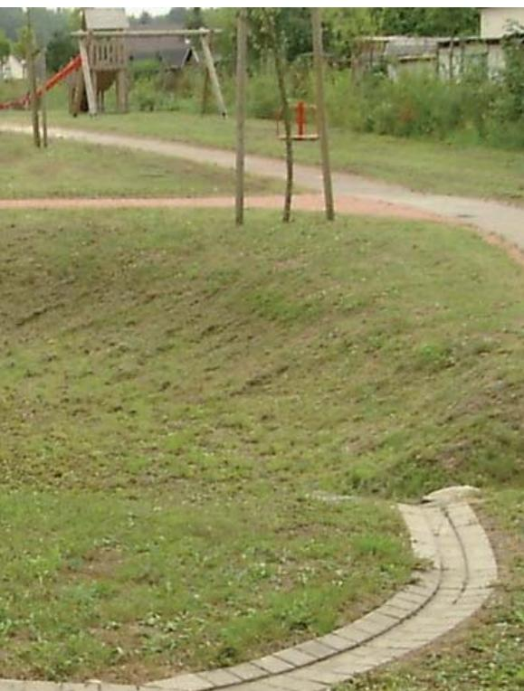
die Zinkgehalte in der technischen Anlage zur Regenwasserversickerung sogar die Vorgaben der Vorsorge- und Prüfwerte nach Bundes-Bodenschutzverordnung zum jetzigen Zeitpunkt sicher eingehalten werden.
